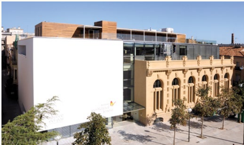
1 Museu del Gas. Edifici de La Energía , 1899 Plaça del Gas, 8
