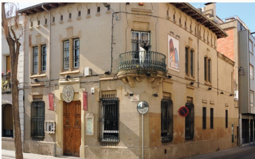
8 Casa Bru - Miralles, 1893 Carrer de Gràcia, 129-131
