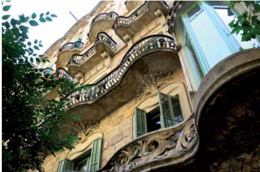
Detalls de la façana de la Casa Antònia Burés.
