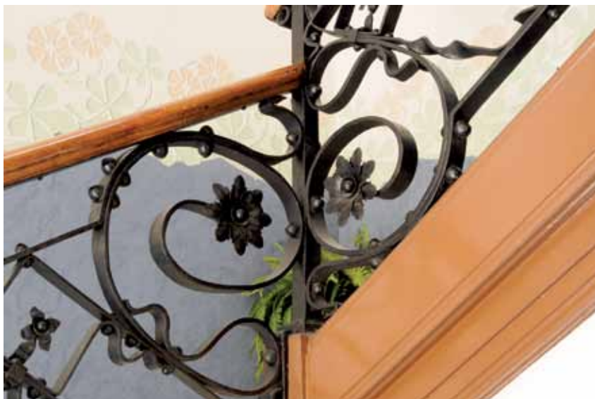
Hotel Suís, estat actual, detalls de la façana i de l'interior.
