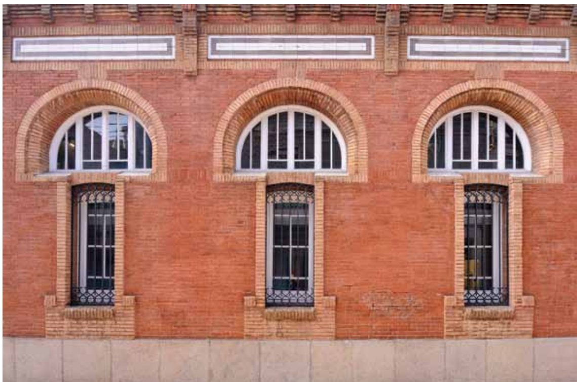
Escoles Públiques. 1895. Estat actual.
