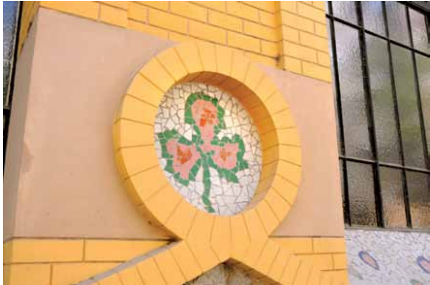
Detalls del Despatx Taulé, estat actual.
