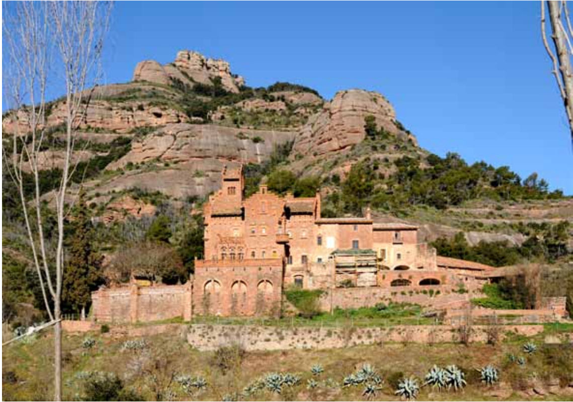
El Marquet de les Roques, estat actual.
