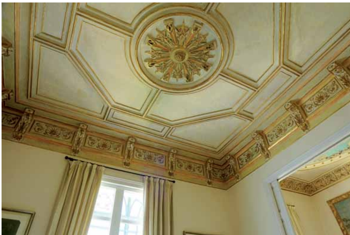
Casa Teodor Prat, sostre d'un saló i galeria posterior del primer pis.
