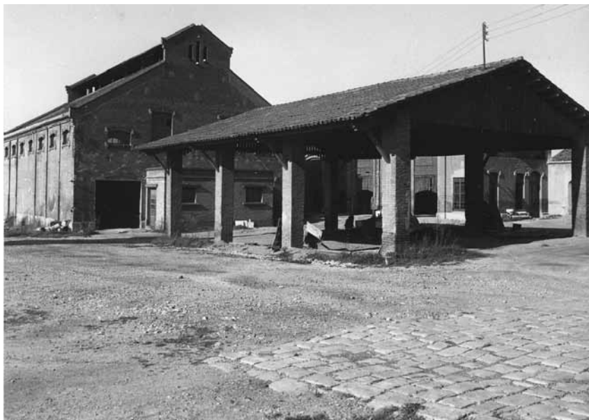
Fàbrica de Gas de La Energía. Fotografia d'autor desconegut. AHFGNF.
