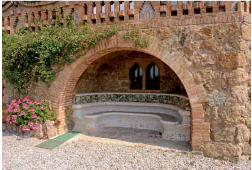
Casa Trias, banc de trencadís i entrada del garatge.
