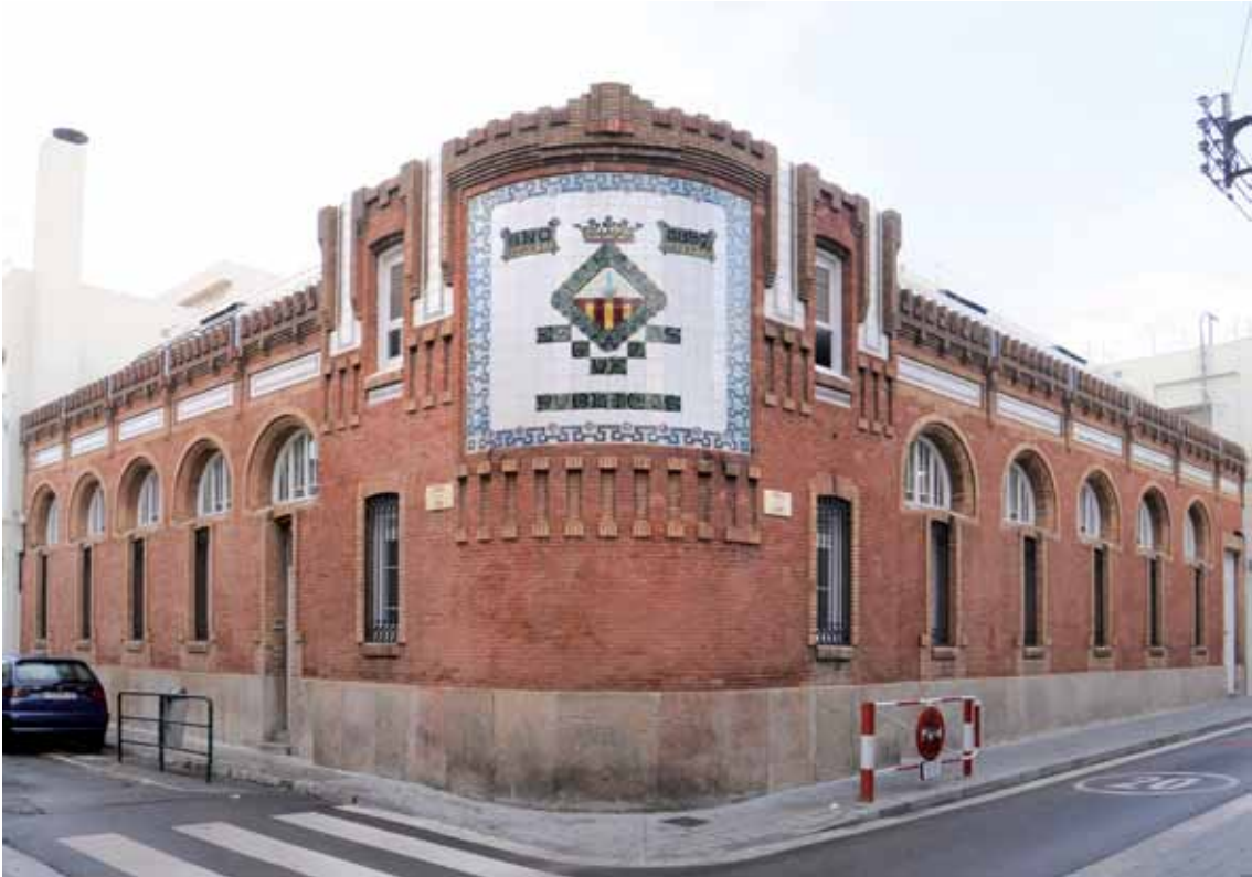
Escoles Públiques. 1895. Estat actual.
