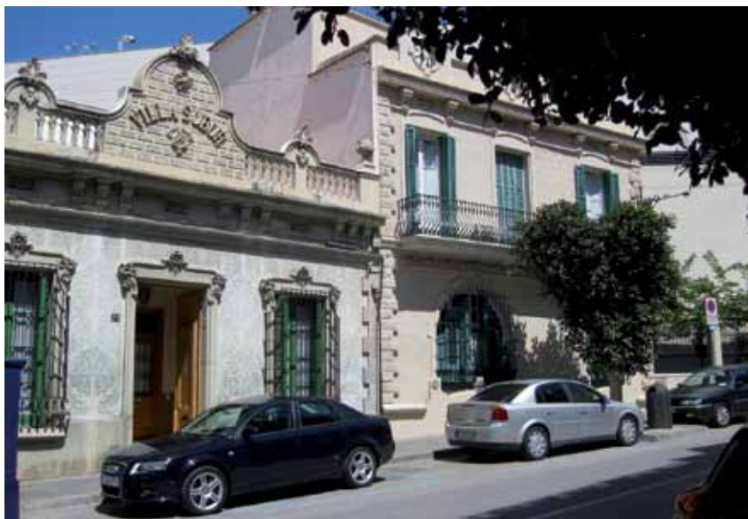
Vil·la Subur a Sitges, a l'avinguda d'Artur Carbonell, núm. 23, estat actual.
