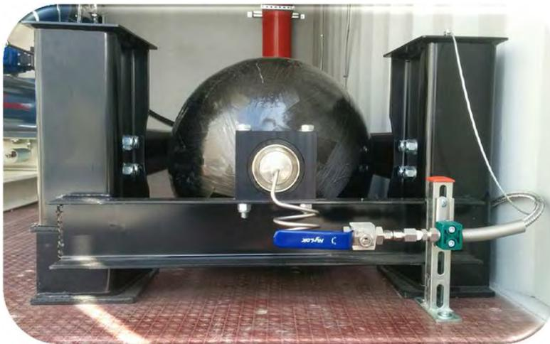
Dentro de soluciones más innovadoras cabe mencionar los sistemas de hidruros metálicos.
