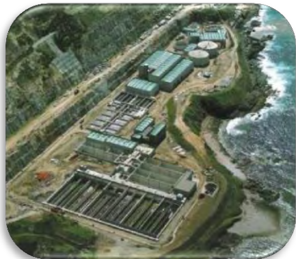
EDAR Bens (A Coruña)
