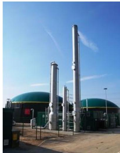
Instalación PWS. Okobit. 300 m<sup>3</sup>/h biogás
