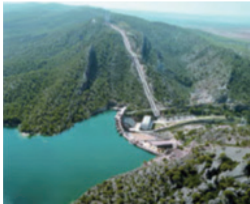
Figura 3.4. Fotografía de la central hidráulica reversible de Bolarque. Fuente: Fotografía de Gas Natural Fenosa (2015).
