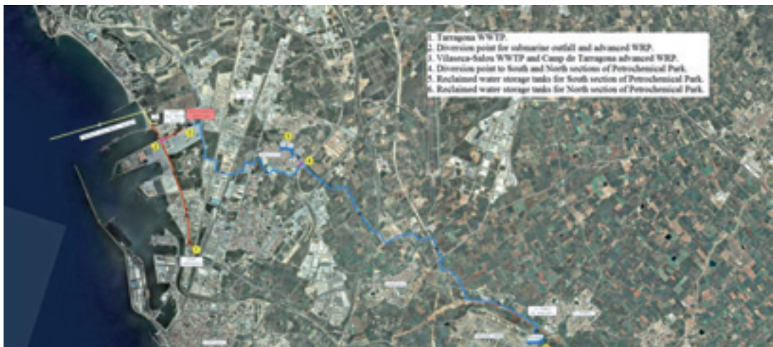
Figura 3.17. Red de distribución de agua regenerada en la estación del Camp de Tarragona (España). Fuente: Fotografía de AITASA (2013).
