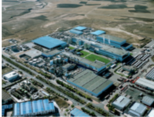
Figura 3.18. Instalaciones de Holmen Paper Madrid, en Fuenlabrada (España). Fuente: Holmen (2016).
