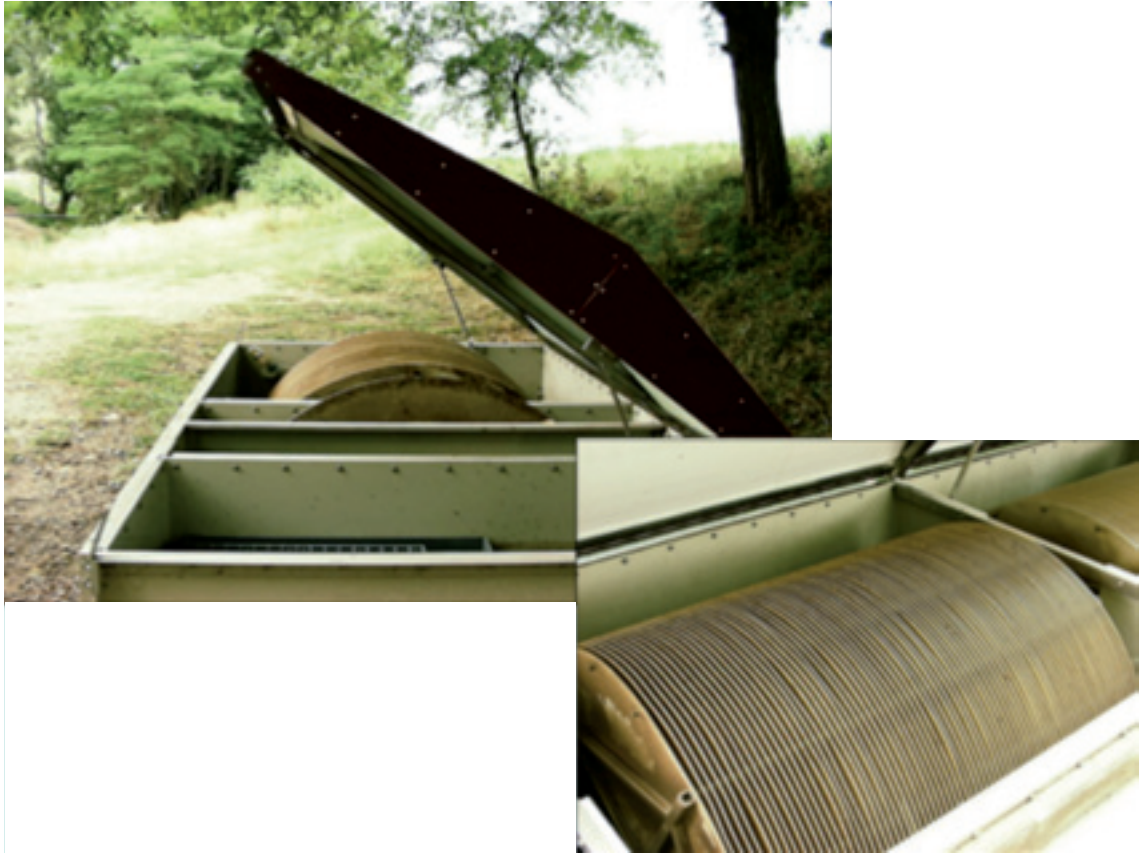
Figura 2.16. Biodiscos en La Garrotxa, Girona (España). Fuente: Fotografía de M. Salgot (2009).
