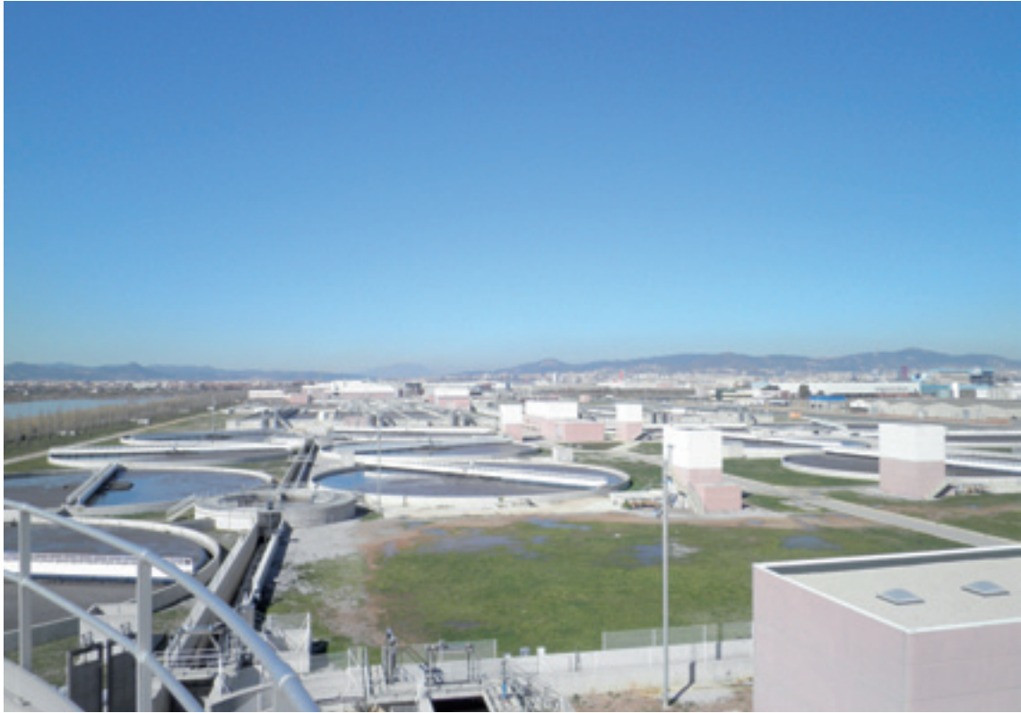
Figura 2.15. EDAR del Baix Llobregat, Barcelona (España).
