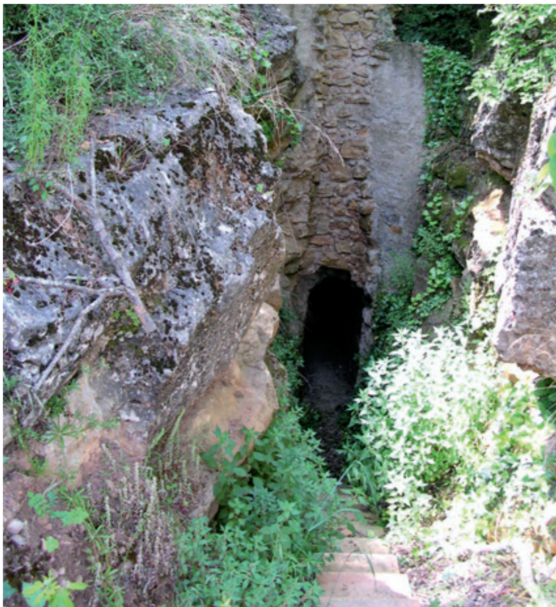
Figura 1.31. Acceso inferior a un pozo de hielo. Poblet, Tarragona (España). Fuente: Fotografía de J.L. de la Peña (2006).
