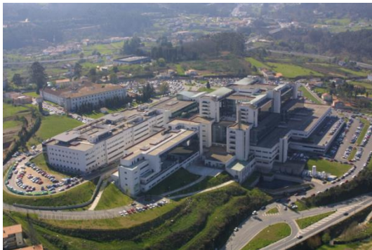
Fotografía 1: Hospital Clínico Universitario
