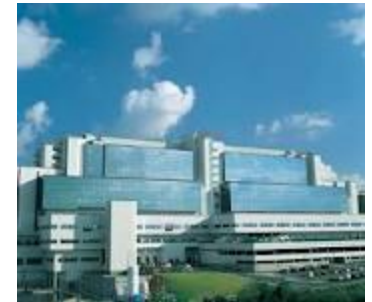
Fotografía 4: Vista Lateral H. Clínico Univ.
