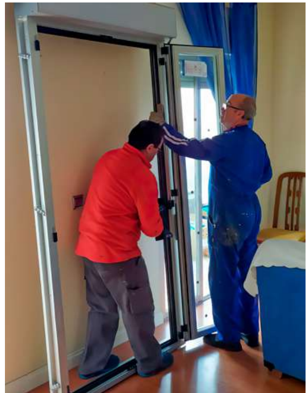
Cambio de ventanas ejecutado con el Fondo Solidario de Rehabilitación Energética.
