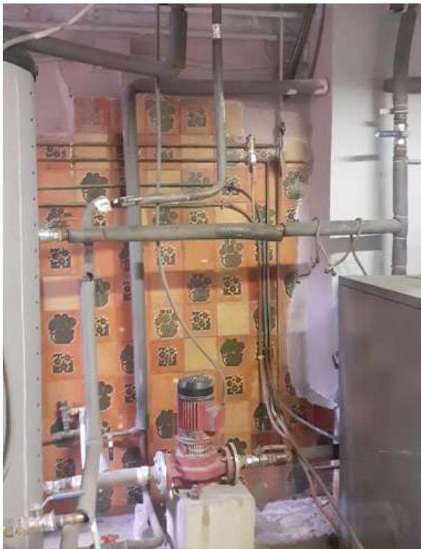
Instalación de una nueva caldera en Fundación Guillén Cano Bote en Trujillo (Cáceres).
