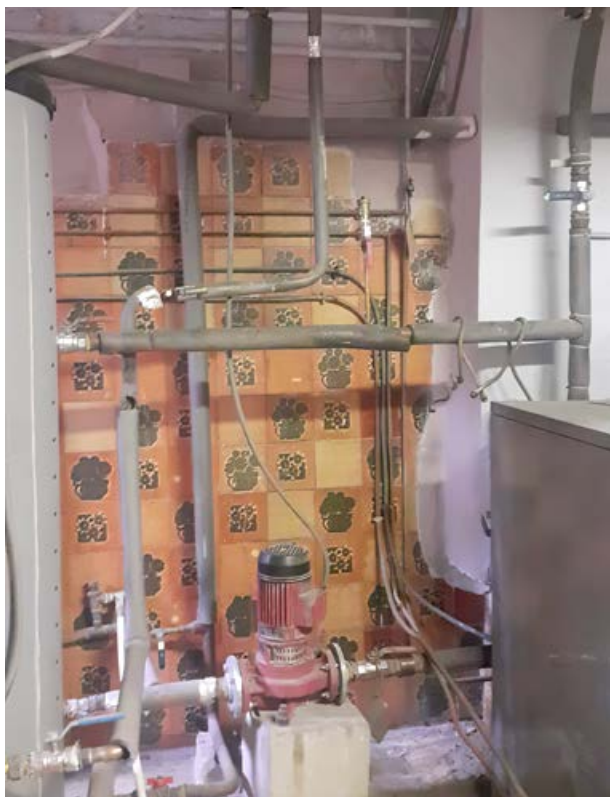
Instal·lació d'una nova caldera a la Fundació Guillén Cano Bote a Trujillo (Càceres).
