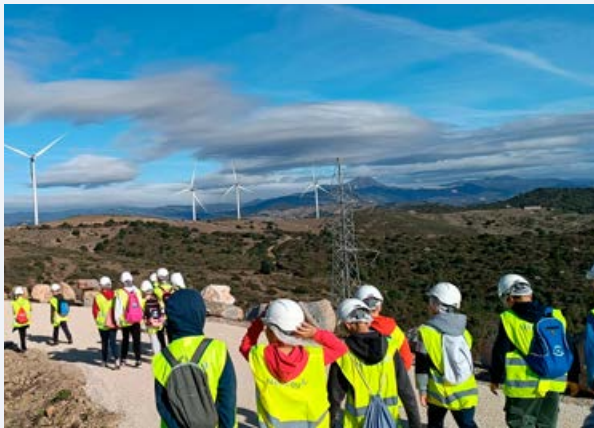
Visita guiada a les instal·lacions del Parc Eòlic El Tesorillo, a San Martín del Tesorillo (Màlaga).
