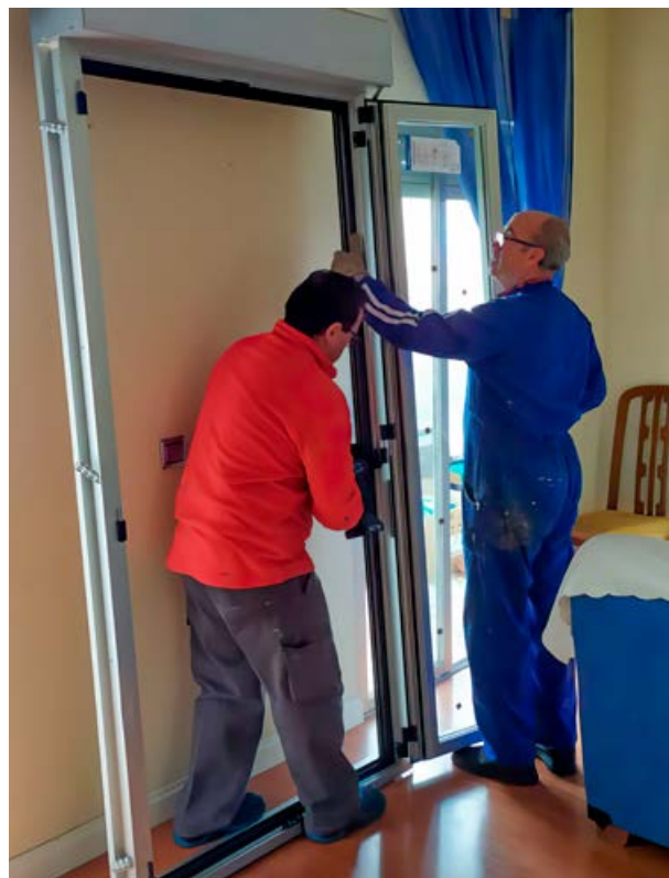
Canvi de finestres executat amb el Fons Solidari de Rehabilitació Energètica.
