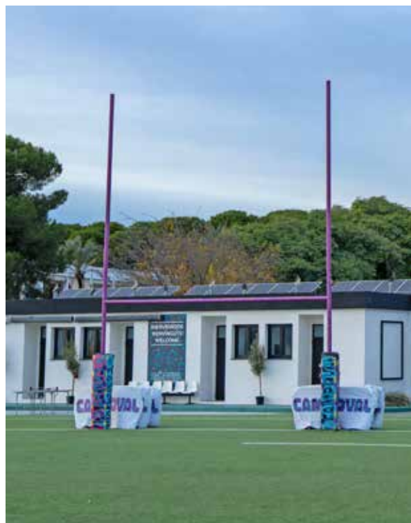
Instal·lació solar a Campoval a Picanya, València.
