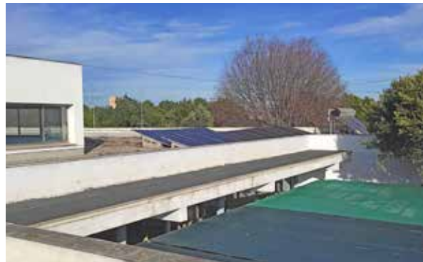
Instal·lació de plaques fotovoltaïques al CEIP Sanchís Almiñana d'Alaquàs (València).
